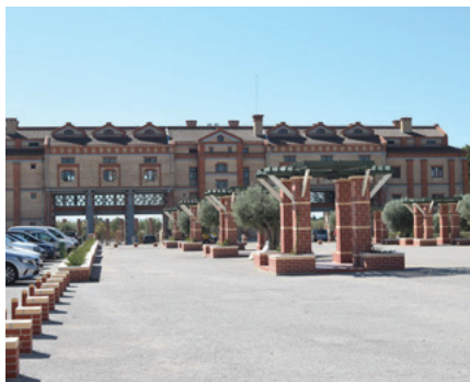
Figura 3. Edifício do Acolhimento.
