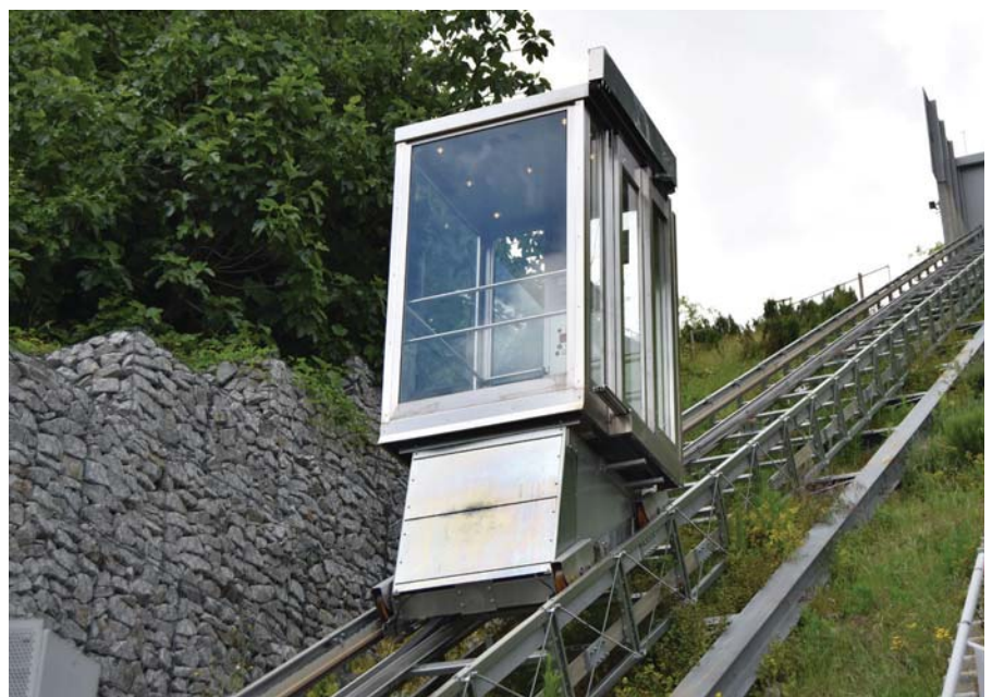
Figura 4. Elevador do Parque da Goldra.
