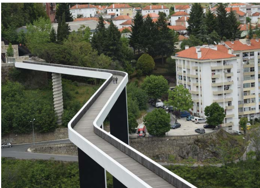
Figura 6. Ponte pedonal sobre a ribeira da Carpinteira.
