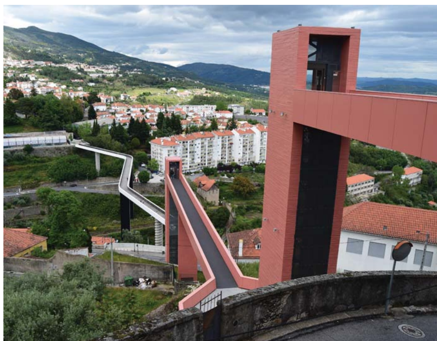
Figura 5. Elevadores do Jardim Público.
