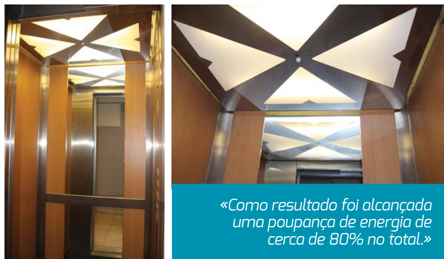
Figura 8. Exemplo prático de aplicação básica em elevador existente: substituição de 2 lâmpadas T8 fluorescentes de 18 W por 2 tubos LED de 7,3 W (redução de mais de 50% no consumo) e aplicação de um sensor de movimento. Como resultado foi alcançada uma poupança de energia de cerca de 80% no total.
